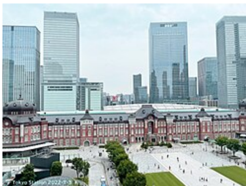
図 5-16 グラントウキョウのツインタワーが建てられたことにより、写真奥の八重洲から手前の丸の内へ出来た「風の道」（WIKIPEDIA）
