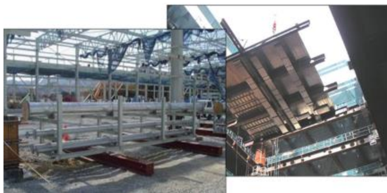
図 6-6 建築・設備一体化工法
