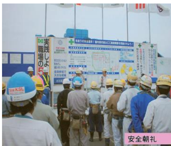
図 6-8 朝、安全確認・作業内容確認・体調確認と安全意識の高揚は重要
