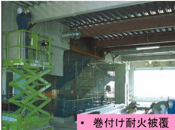
図 6-12 耐火被覆の無害化
