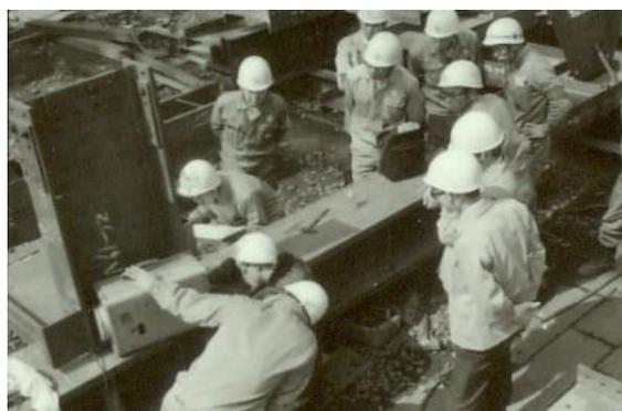
図5-19 鉄骨ファブrikレーター工場における超音波探傷検査(1968)
