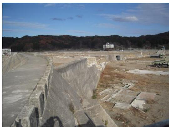
図5-8 2011年東日本大震災の津波で破壊された岩手県田老町の巨大防潮堤
