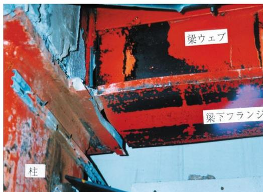
図5-7 兵庫県南部地震で破断した建築鉄骨の柱—梁接合部
